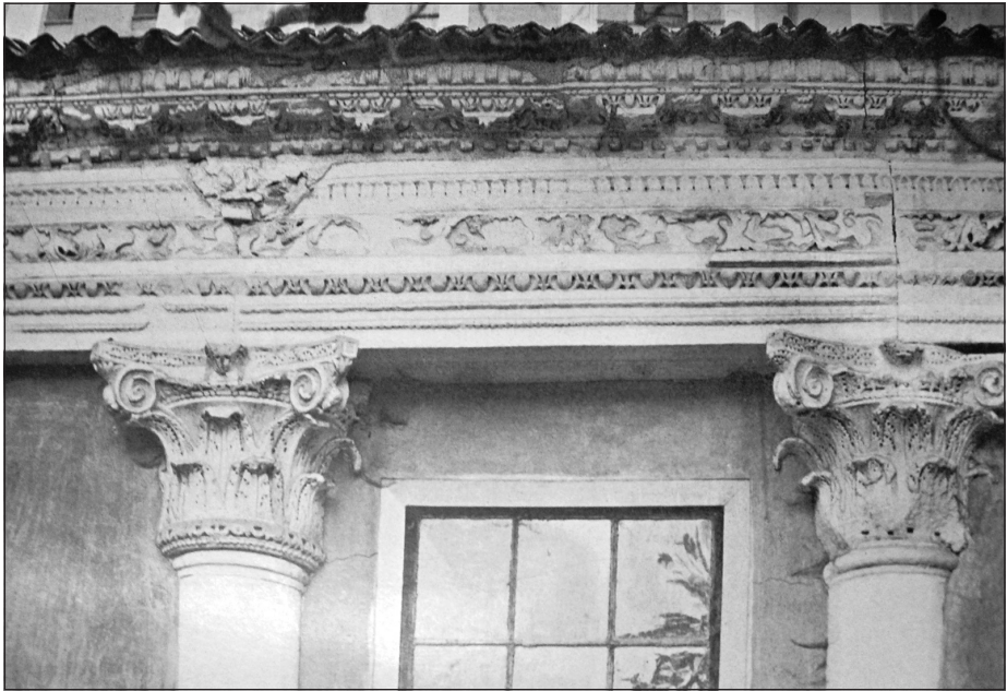
Західний фасад церкви Св. Йоана (Студійського), Константинополь
